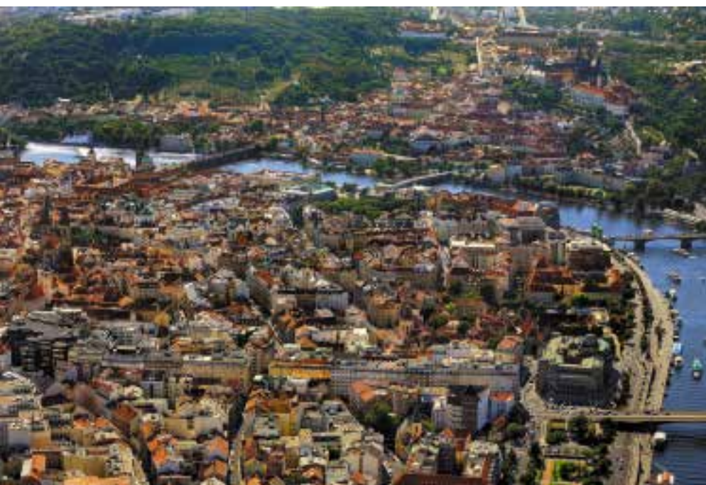
Struktura Starého Města (pohled od východu).
