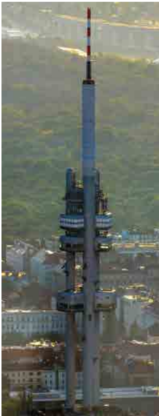
Žižkovská televizní věž je nejvyšší stavbou Prahy (216 m).
