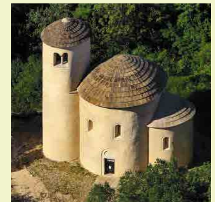
Rotunda of Sts. George and Adalbert on Říp Mountain.
