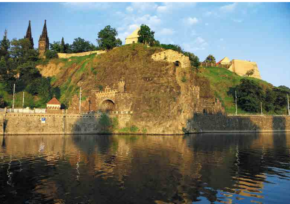
Skala Wyszehradzka z pozostałościami pierwotnego podparcia, tunel u jej podnóża pochodzi z początków XX wieku.
